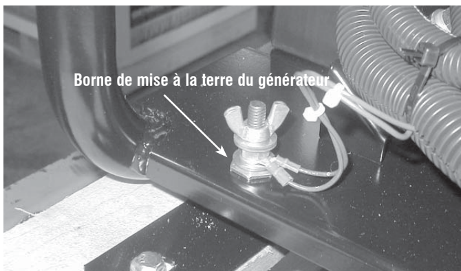
Schéma 13 - Mise à la terre du générateur
